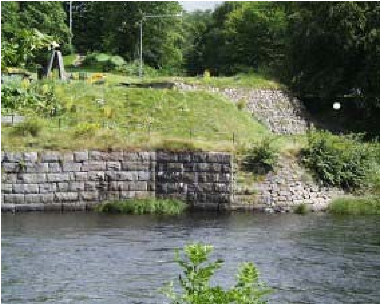
Brofundamenten från den gamla bron är fortfarande väl synliga
