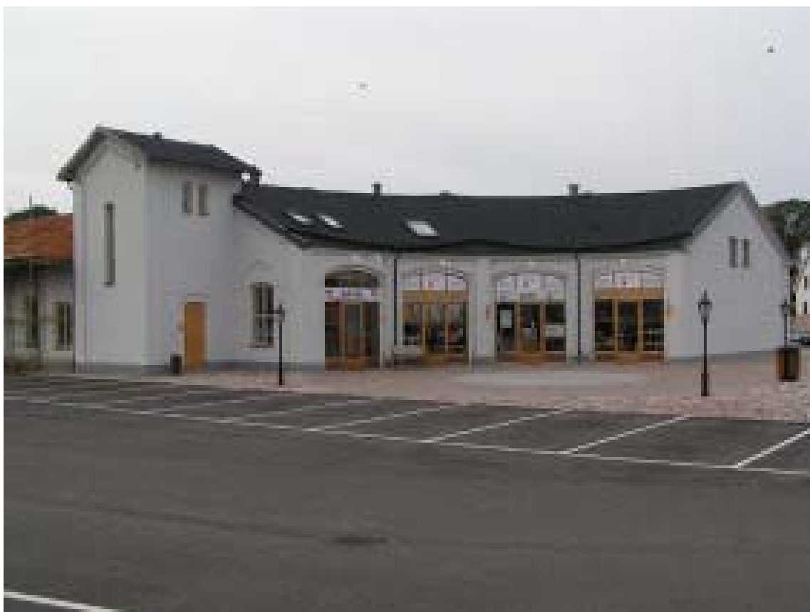
Falkenbergs Järnvägars renoverade fd lokstall
